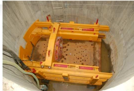
a) Poço de ataque: instalação do equipamento
