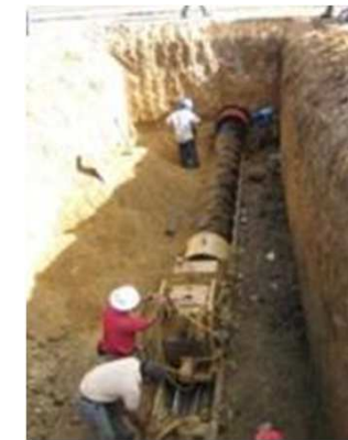
Perfuração do solo e inserção da tubagem nova
