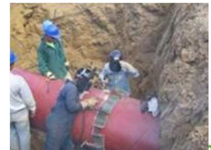
Soldadura da tubagem nova
