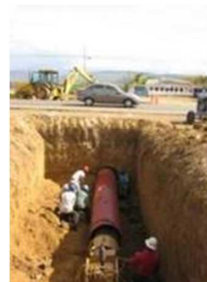
Perfuração do solo e inserção da tubagem nova
