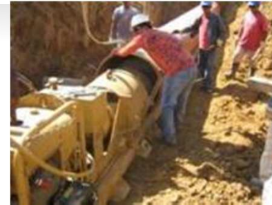
Cabeça de corte rotativa fixa a um trado
