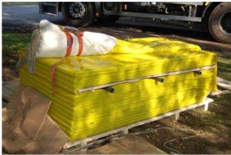
a) Manga flexível preparada para inserção
