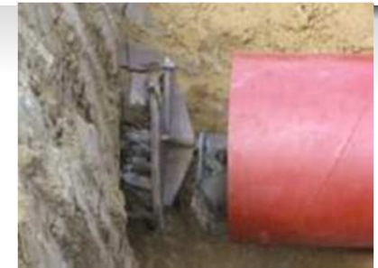
Cabeça de corte rotativa fixa a um trado
