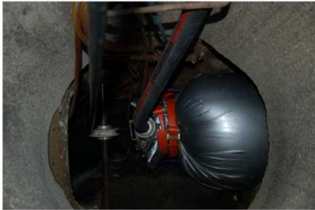
e) Tubagem em fase de cura
