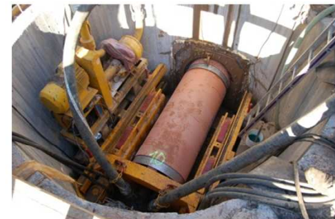
d) Início do empurre do troço de tubagem
