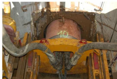
e) Empurre do troço de tubagem
