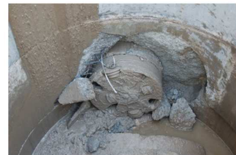
f) Poço de recepção: chegada da cabeça
