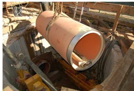
c) Colocação de troço de tubagem
