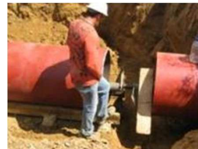
Soldadura da tubagem nova
